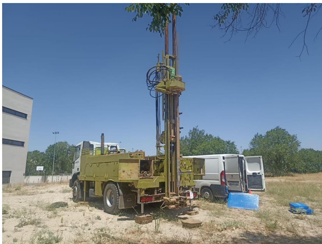
Figura Nº 5.- Imagen de la ejecución del sondeo mecánico y rotativo con extracción continua de testigo referido como S-01.
