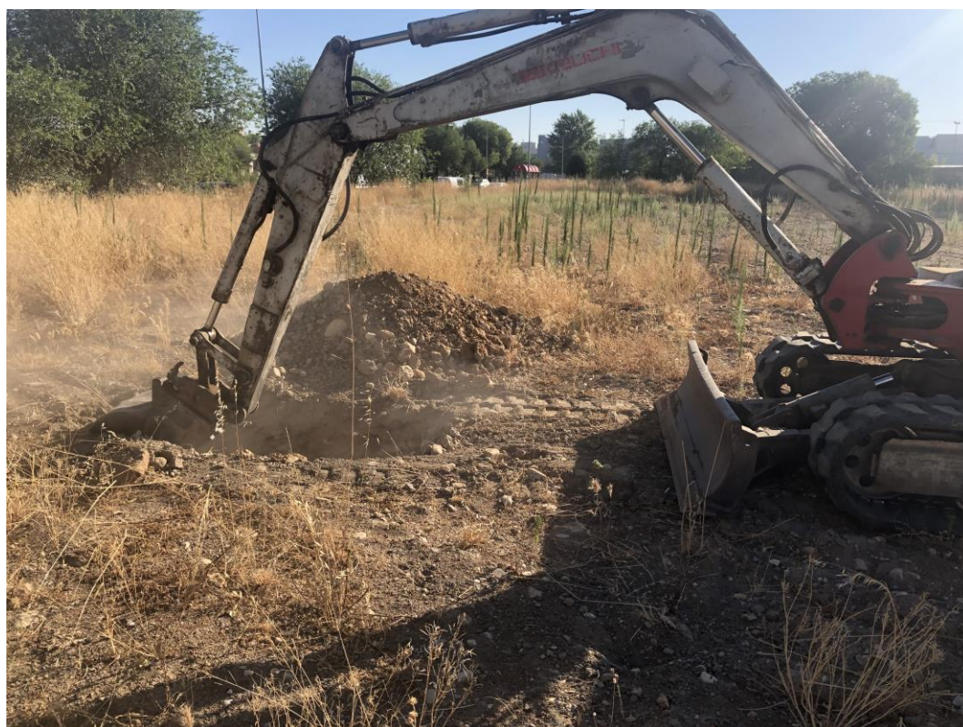
Figura Nº 7.- Fotografía de la ejecución de la calicata referida como C-02.
